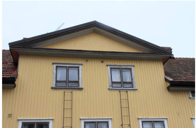
Kuva 30. Kadun puoleisen julkisivun kattolyhty. Talon korjauksen yhteydessä vanhat kattotiilet puhdistettiin ja asennettiin takaisin paikoilleen. Kuva nro 8010.
