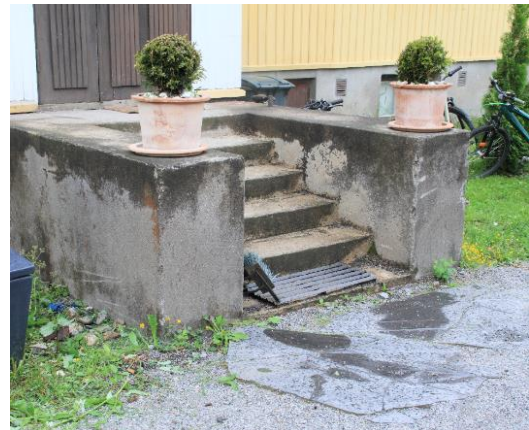
Kuva 26. Pääsisäänkäynnin betonista valetut portaat ovat alkuperäiset. Kuva nro 8002.
