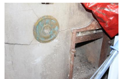
Kuva 58. Entisen pyykkituvan muuripataa ei ole purettu. Huonetta käytetään nykyisin varastona. Kuva nro 8034.
