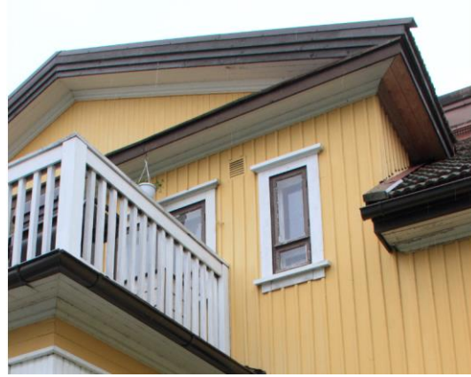
Kuva 28. Kattolyhtyjen päätykolmioita on korostettu voimakkaalla listoituksella. Seinien ulkuvuorauksen ja katon lappeiden alavuorauksien välissä on muotoiltu lista, joka korostaa rakennuksen klassistista ilmettä. Kuva nro 8005.
