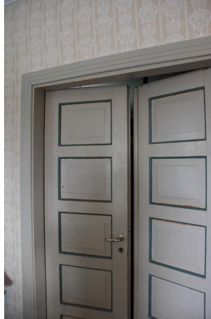
Kuva 39. Salin ja eteisen välinen pariovi. Ovi on alkuperäinen peiliovi. Kuva nro 8024.
