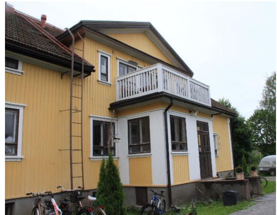
Kuva 24. Simolan talon pohjoisjulkisivu eli pihan puoleinen julkisivu. Talon korjausten yhteydessä kuistin yllä olevan parvekkeen paneloitu kaide on muutettu rimoitukseksi. Kuva nro 8000.
