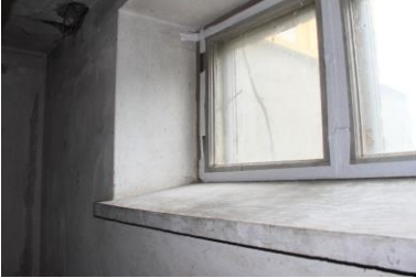
Kuva 59. Pihan puoleiset ikkunat kellarissa ovat isommat kuin kadun puoleiset. Ikkunat puitteineen ovat alkuperäiset. Kuva nro 8031.
