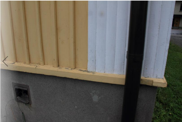
Kuva 29. Simolan talon leveät kulmalistat on uurrettu antiikin pylväitä muistuttaviksi 1920-luvun klassismille tyypilliseen tapaan. Vaikka rakennuksen ulkoasu on pelkistetty, niin yksityiskohtien huolellinen miettiminen näkyy esimerkiksi kulmistaan uurretuissa peiterimoissa. Kuva nro 8006.
