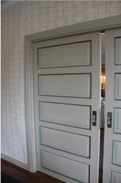
Kuva 38. Salin ja ruokasalin välinen liukuovi on alkuperäinen peiliovi. Ovet liukuvat seinärakenteen sisään. Kuva nro 8022.
