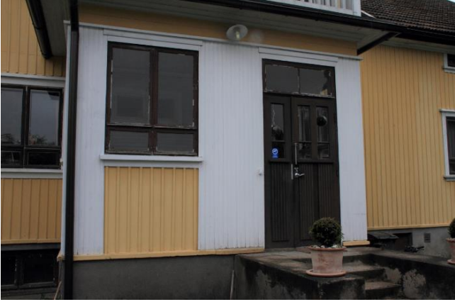
Kuva 27. Kuistin alkuperäinen ovi on kunnostettu kauniisti. Kuistin ikkunat ovat vastaavat kuin pääkerroksen muutkin ikkunat. Kuistin kulmissa sekä ikkunan ja oven välissä on vastaavat leveät uurrettu kulmalaudat kuin talon muissakin kulmissa. Kuva nro 8003.
