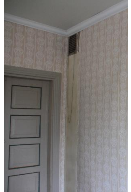
Kuva 40. Salin nurkassa näkyy hormisto, johon liittyy alkupeärinen ilmanvaihtoluukku katonrajassa. Kuva nro 8023.
