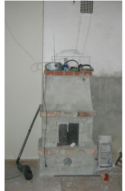
Kuva 55. Alkuperäinen keittiö on muutettu pienemmän asunnon asuinhuoneeksi ja hellan paikalle on muurattu vanhoista tiilistä tulisija. Kuva Jussi Maaniitty.
