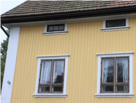
Kuva 31. Pitkien julkisivujen ikkunoiden yllä on ns. haukkaikkunat vintin kylmiin väliköihin. Ikkunoiden uloin lasi on 1920-luvun klassismille tyypilliseen tapaan samassa tasossa kuin ulkoverhous. Kuva nro 8011.
