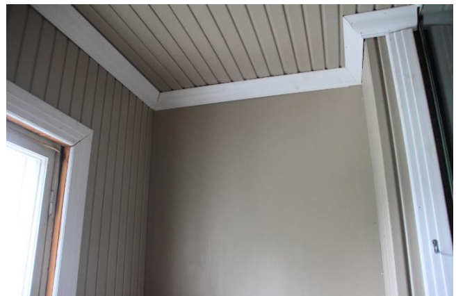
Kuva 52. Itäpäädyn pienemmässä asunnossa katto on paneloitu. Listoitus on toteutettu vanhan mallin mukaan. Kuva nro 8051.
