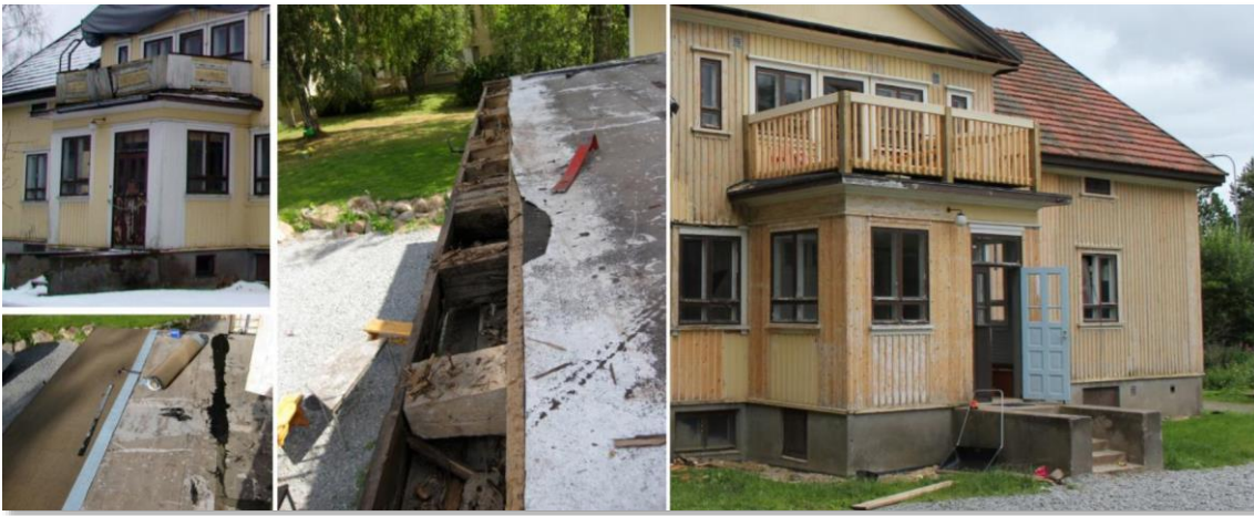
Kuva 9. Ote nykyisen omistajan esityksestä Entistä parempi – luentosarjassa vuonna 2013. Vasemmassa yläkuvassa näkyy kuistin ja parvekkeen korjauksen lähtötilanne, muissa kuvissa korjauksen työvaiheita ja oikealla lopputulos ennen kuistin maalaamista. Kuvat: Jussi Maaniitty.
