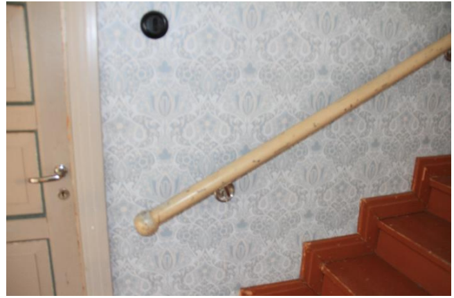
Kuva 50. Pääportaikon seinän puoleinen kaide on siro puukaide. Kaide on alkuperäinen. Valokatkaisijoina on käytetty alkuperäisiä katkaisijoita tai niitä vastaavia katkaisijoita. Kuva nro 8047.
