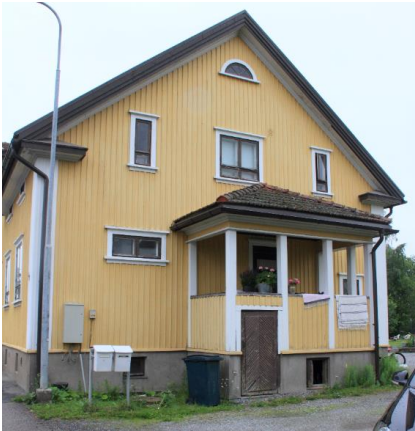
Kuva 23. Simolan talon itäpääty. Itäpäädyn avokuistin kaide on uusittu taloa remontoitaessa umpikaiteeksi. Kaiteena oli aiemmin avoin ristikko. Kuva nro 7997.
