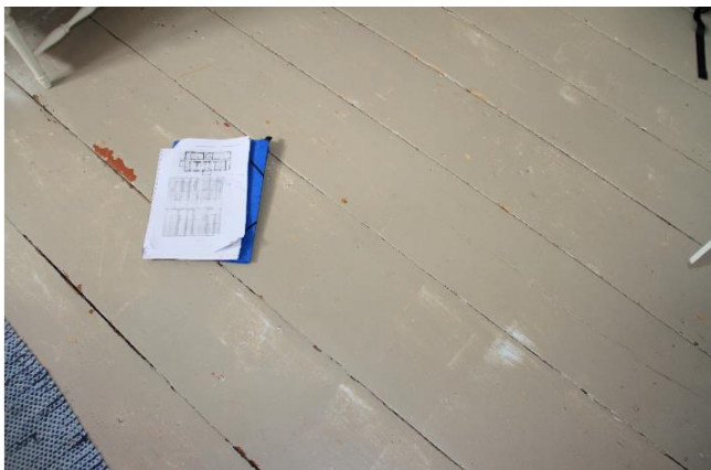
Kuva 51. Talon itäpäädyssä entisen tuvan lattia on toteutettu paikalla aiemmin sijainneen talon lattialankuista. Leveimmät lankut ovat lähes 30 cm leveitä. Kuva nro 8049.
