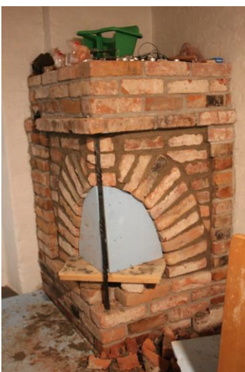
Kuva 56. Saunaosaston muutostöiden yhteydessä vanhoista tiilistä on muurattu takka. Kuva Jussi Maaniitty.
