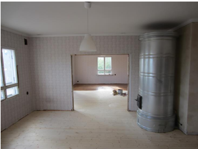
Kuva 41. Näkymä ruokasalista kohti salia. Pöytäuuni on toteutettu 2010-luvun korjausten yhteydessä. Huonokuntoisen välipohjan eristeet uusittiin korjausten yhteydessä. Lattia uusittiin alkuperäisen kaltaiseksi lakatuksi lautalattiaksi. Kuva on otettu, kun lakkauksen on ollut vielä kesken. Kuva Jussi Maaniitty.
