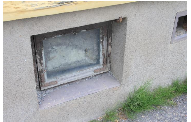
Kuva 34. Kellarin ikkunoiden karmeja ei ole vielä kunnostettu. Ne ovat alkuperäisiä. Kuva nro 7994.
