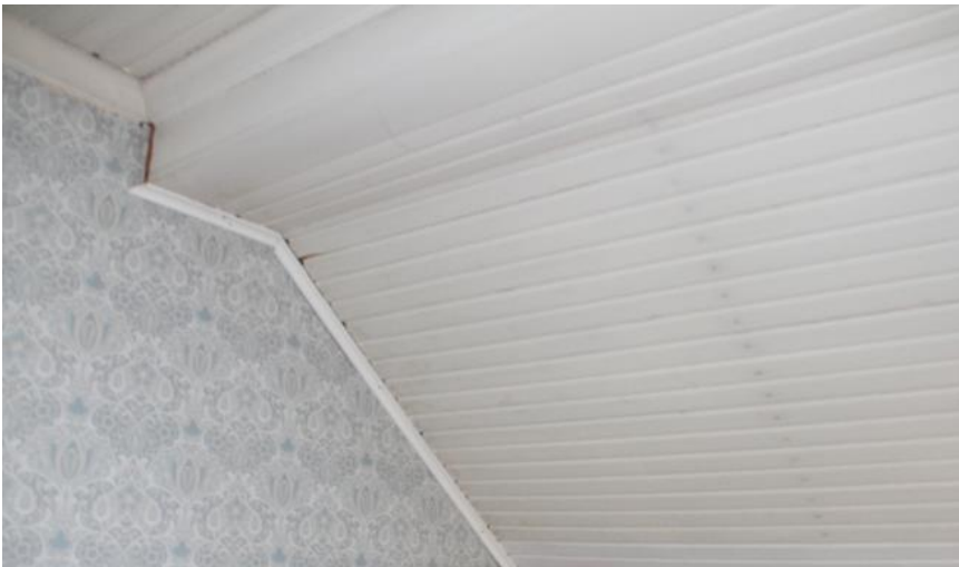
Kuva 48. Yläkerran katto on paneloitu. Kuva nro 8045.
