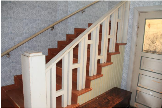
Kuva 49. Pääportaikon kaiteen pienat on yhdistetty toisiinsa porrastetusti. Portaiden alla on alkuperäisellä paikalla wc-tilat, joihin johtaa peiliovi. Kuva nro 8040.
