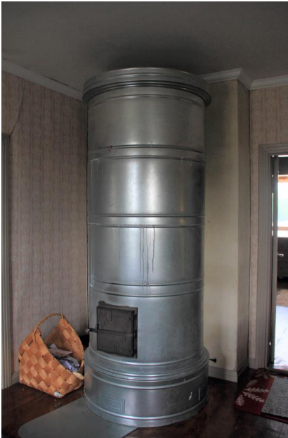
Kuva 53. Ruokasalin nurkkaan on toteutettu 2010-luvulla pöytäuuni. Uuni odottaa vielä maa- laamista. Kuva nro 8026.
