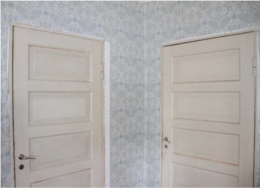
Kuva 47. Kuva Yläkerran viisipeiliset ovet ovat myös alkuperäiset. Niiden peilejä ei ole korostettu vastaavaan tapaan kuin alakerran ovissa tummalla raidalla. Ovien listoitus puuttuu vielä. Kuva nro 8046.
