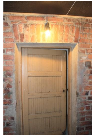
Kuva 64. Kellarin tiiliseinissä näkyy oviaukkojen holvaukset. Ovet heloituksineen ovat alkuperäisiä. Kuva nro 8039.
