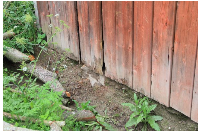
Kuva 36. Vajan perustuksena on nurkkakivi. Kuva nro 8021.
