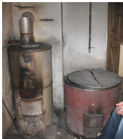
Kuva 57. Saunan entinen kivas ja vesipata on purettu muutosten yhteydessä. Kuva Jussi Maaniitty.
