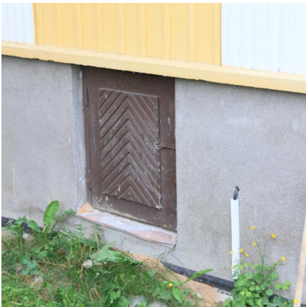
Kuva 25. Kuistin alustaan johtava luukku on alkuperäinen. Vastaava kalanruotokuvioinen ovi johtaa rakennuksen päädyn avokuistin alle. Kuva nro 8001.
